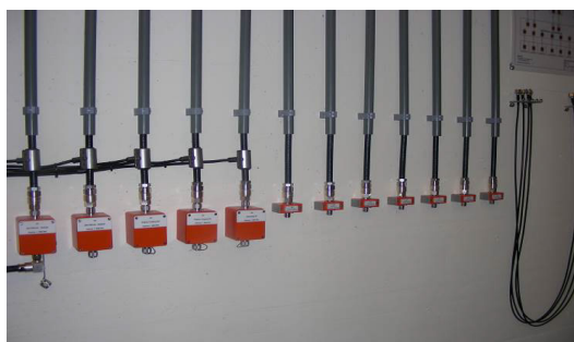
Fig. 34: Installazioni di radiocomunicazione nel centro telematica con cavi coassiali (destra) I segnali vengono amplificati dai ripetitori attivi prima di essere trasmessi ai posti di comando.
