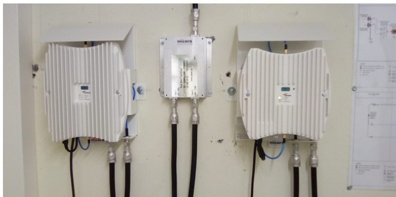
Fig. 35: esempio di un ripetitore Polycom a banda larga attivo (a sinistra), di un duplexer (al centro) e di un ripetitore a banda larga per la telefonia mobile (a destra).
