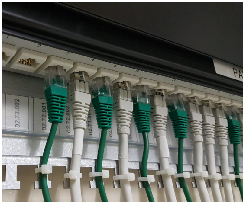
Fig. 46: pannello di distribuzione con raccordi numerati.
